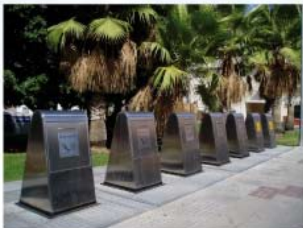
Plan de contenedores soterrados instalados en el casco urbano
