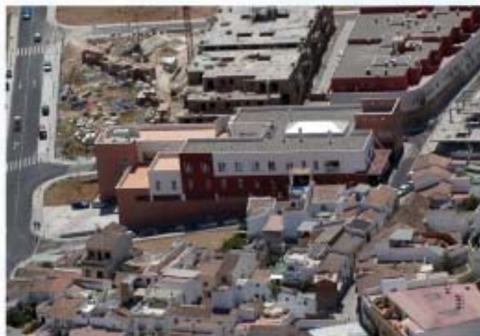
Centro de Salud en construcción, año 2005
