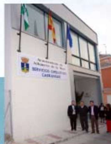
Nueva nave de Servicios Operativos, año 2007
