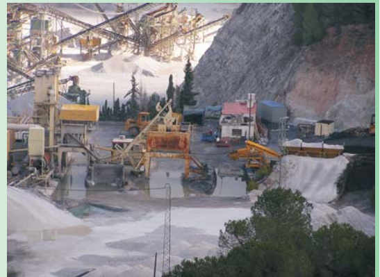
Camino de unión entre cuencas. Enero 2006.
